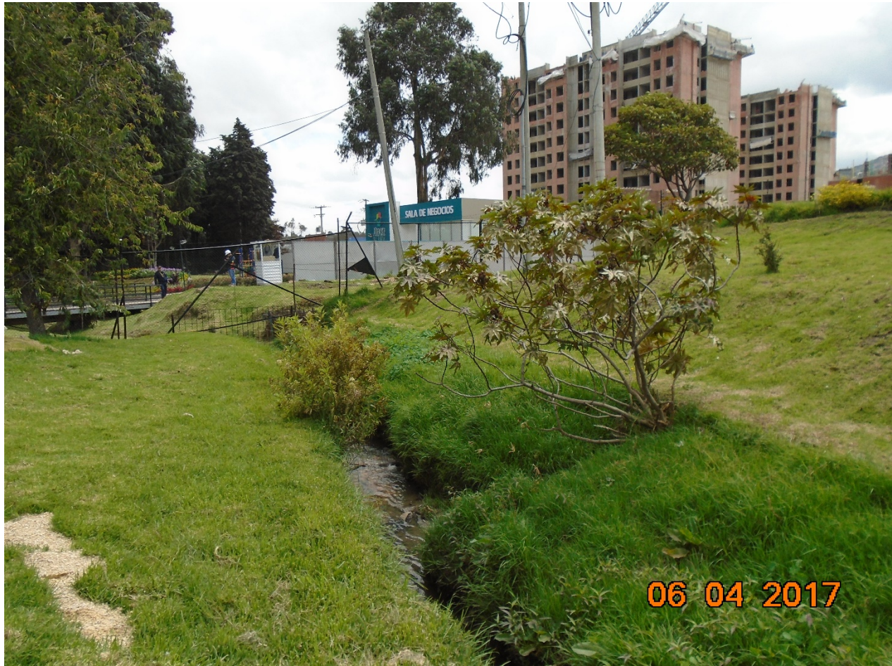
Fotografía N° 3. Punto de intervención del desarenador la coordenadas tomadas en campo son: X=95144,50 y Y=92633,34
